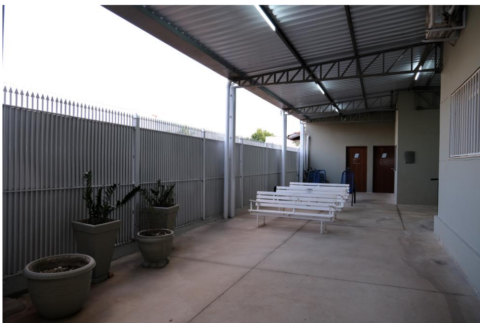
Foto 24: Sala de Espera.
