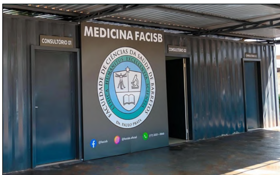
Figura 10. Container modificado para salas de atendimento na ESF do Cristiano de Carvalho.
